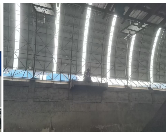
新建储煤棚雾炮
